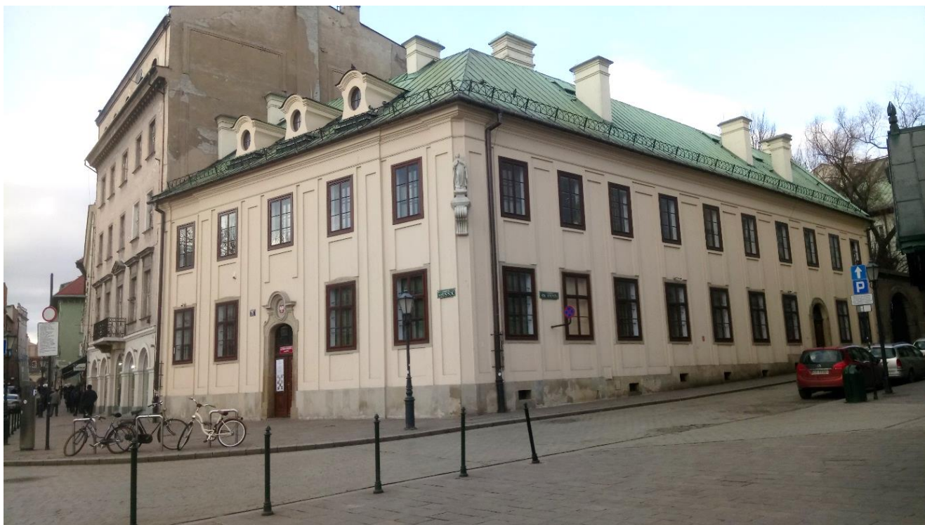
Pierwszy gmach Szkoły Handlowej mieścił się w budynku Miejskiej Kasy Oszczędności w latach 1882 – 1905 (róg ul. Siennej i ul. św. Krzyża); fot. U. Siwek - Faszyńska
